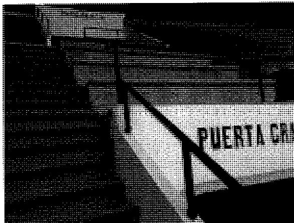
Fotografía nº 54: Barandilla existente en salida a tendido.
