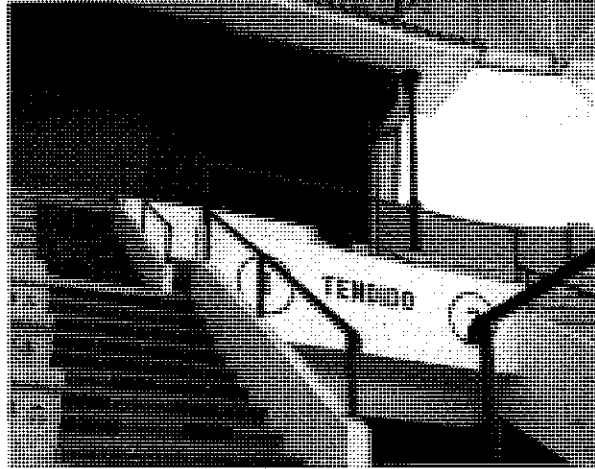
Fotografía nº 533: Escal. existente en ascensor.
